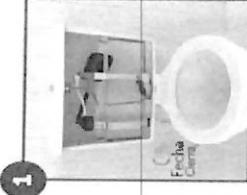
1. Feche a válvula de alimentação da caixa de descarga.
